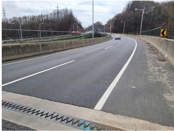
교량 상부 전경
