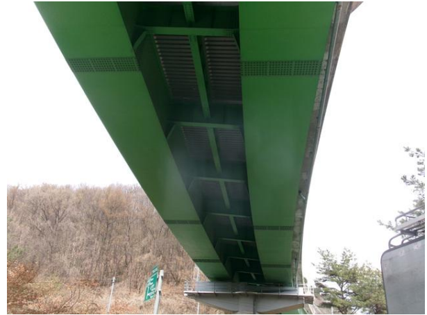
바닥판 하면 및 거더 전경
